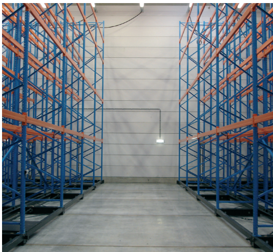
Sistema de control de la iluminación
