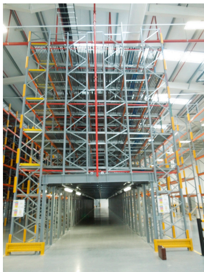
Instalace válečkových drah s tunelem.
